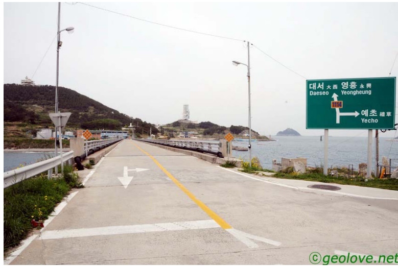
사진 17 추자교(오른편에 구 추자교 흔적, 등대전망대가 왼편으로 멀리보인다)
