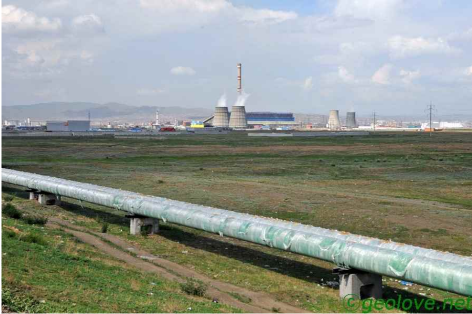
사진 3 울란바타르 화력발전소와 온수 파이프
